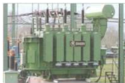
transformátor na vysoké napětí
